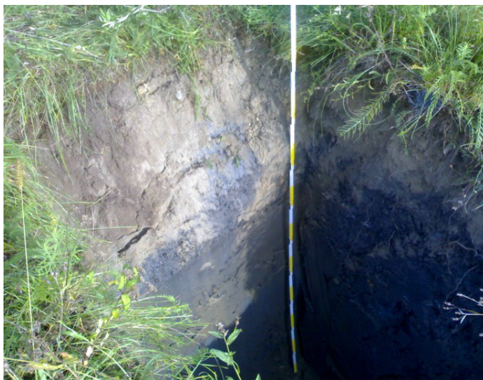
Fig. 2.4.2. Escavazione trincee con verifica sistematica della profondità di scavo.
